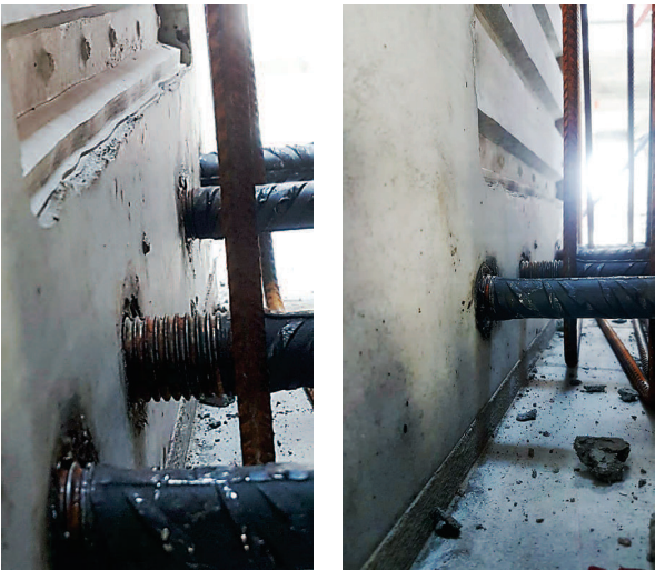
Detaliu continuare armătură prin cuple filetate în nod stâlp - grindă
